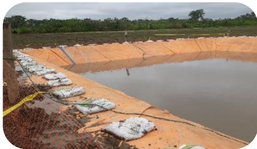
Construcción de piscinas impermeabilizadas para almacenamiento/tratamiento de agua de Pruebas hidrostáticas.
