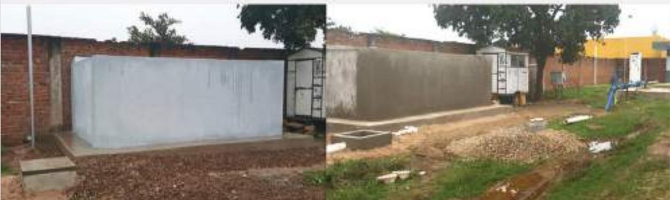
Pozo JDU - 3 : Construcción Tanque de Purga y Sala de Cloración
