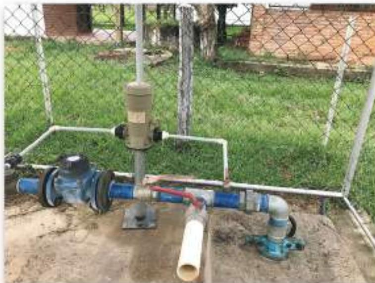
Instalación de Sistema de cloración en el pozo 1 de la localidad de Peji
