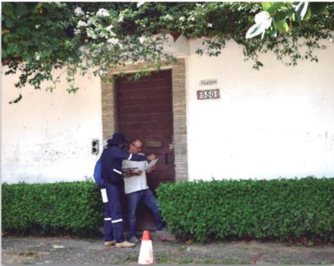
Renovación de la red de Agua Potable Barrio Sirari UV 58
